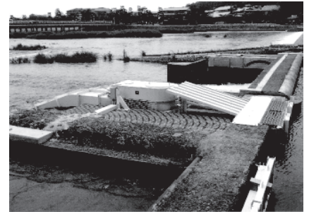
図表 15 河川内の取水堰の落差を利用した発電
