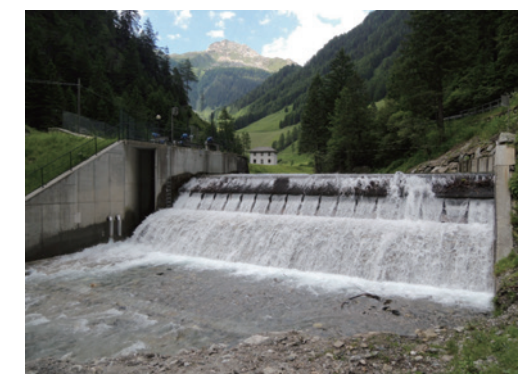
写真6- コアンドスクリーン (取水量を維持したまま除塵, メンテナンスフリー, 安全)
