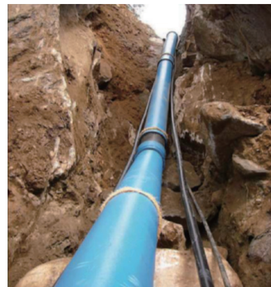
写真4- 崖等の険しい場所に適用する水圧管 (左) と接手部 (設置工期の短縮, 雪崩やげけ崩れにも強い)
