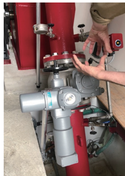
写真5- 超小型化電動入口弁
