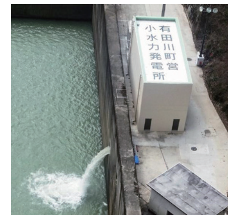
<河川維持放流を利用した小水力発電> 有賀川町HP : https://www.town.aridagawa.lg.jp/top/kurashi/kankyo/1/2245.html
