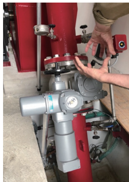
写真5- 超小型化電動入口弁
