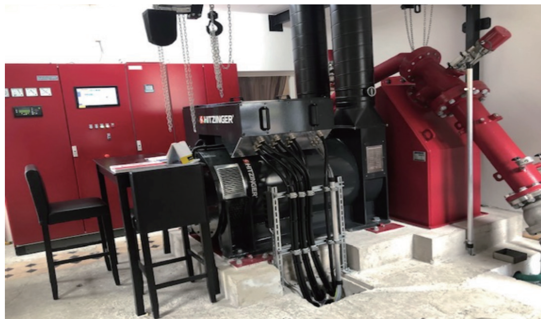
写真1- 狭い建物内での更新事例（出力430kW）
