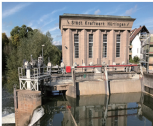
図1-SN社の水力発電所（SN社提供）
